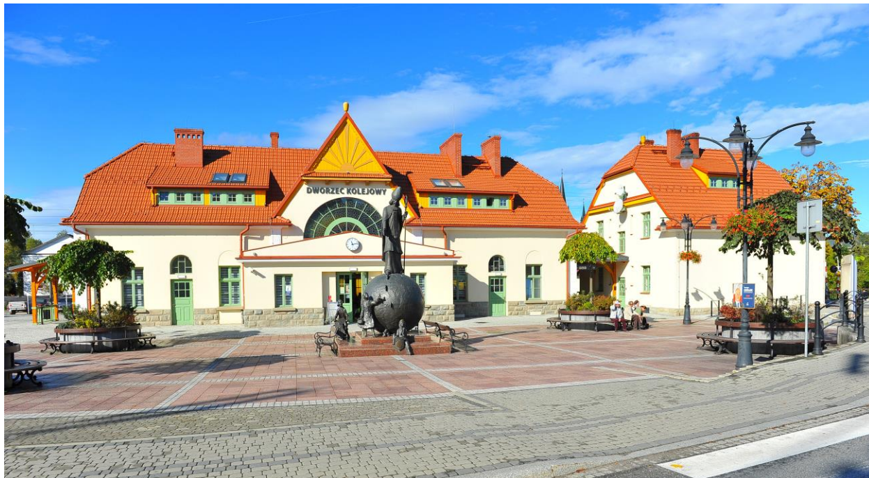
fot. J. Ciepliński – Budynek dworca kolejowego
